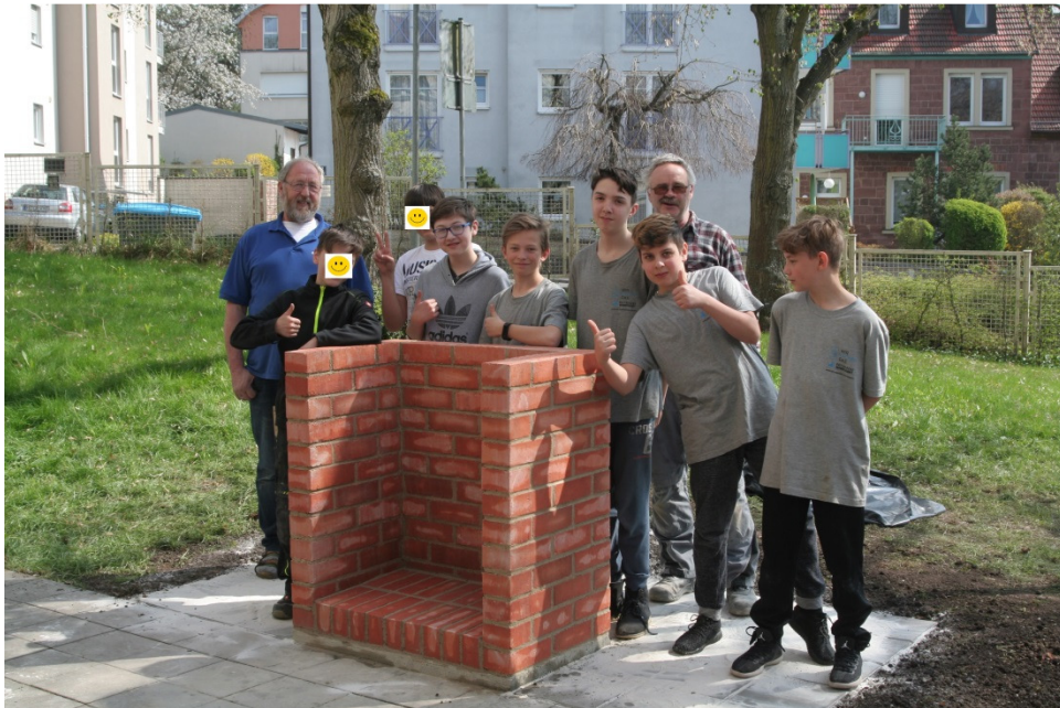
Schüler der Klasse 7b GT präsentieren stolz den Steingrill, den Sie unter Anleitung von Georg Kiesel und Alois Servatius vom Unternehmen Otto Heil Hoch-Tief- Ingenieurbau und Umwelttechnik sowie in Kooperation mit dem bfz Schweinfurt errichtet haben
